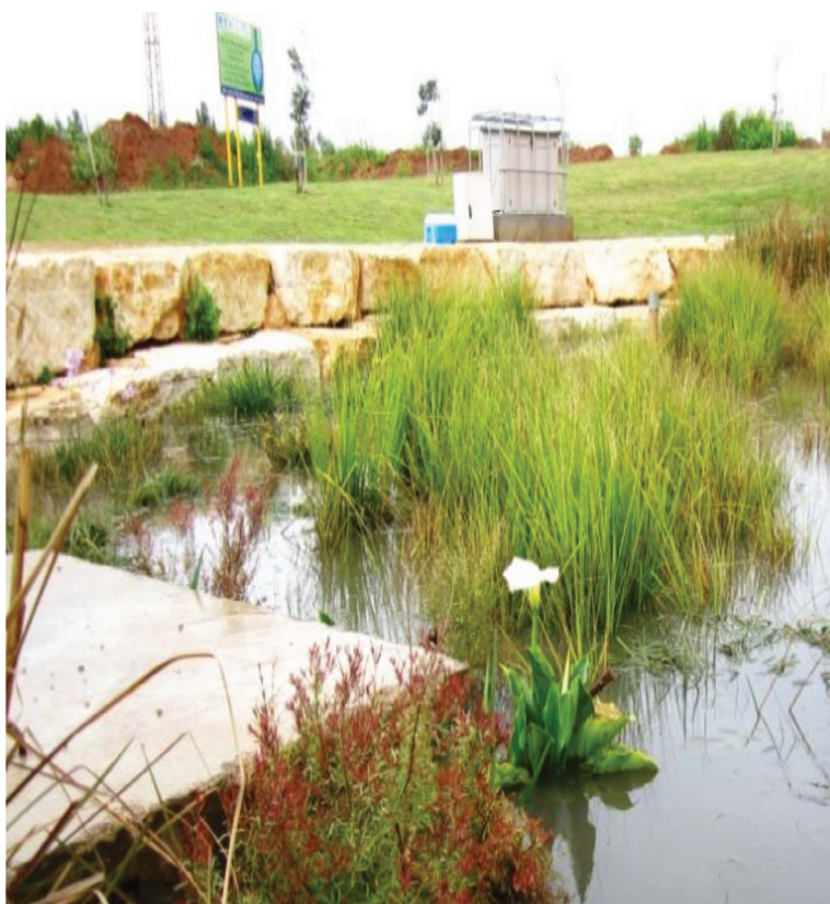
איור 40: הביופילטר לאחר אירוע גשם
