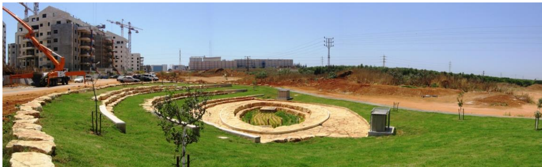
איור 4: מתקן החלויץ של מערכת הביופילטר דואלית בכפר סבא עבור איסוף מי נגר עירוני והעשרת מי התהום בחורף תוך שיקום מי תהום בקיץ
